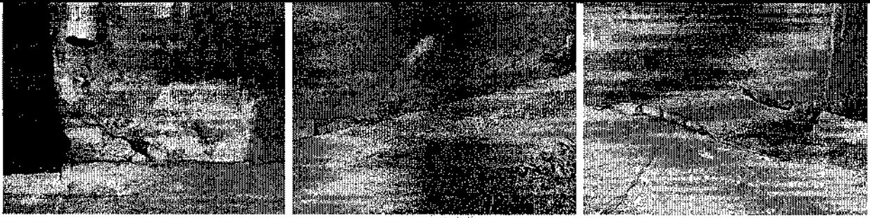
Фото 5 – 7. Локальные разрушения защитного штукатурного слоя цокольной части здания. Дефект эксплуатационного характера. Вызван промерзанием насыщенной влагой кладки и дальнейшим её разрушением, а также внешними механическими воздействиями (включая атмосферные осадки).
